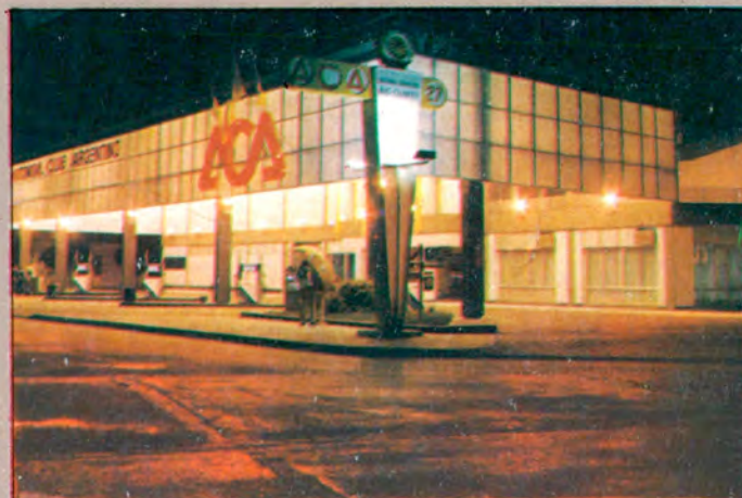
Centro Servicial Río Cuarto (CBA) Nueva obra
